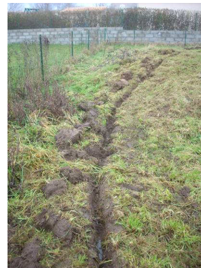
Figure 36. Réalisation d'une tranchée pour enfoncer la bâche. Source : Biotope
